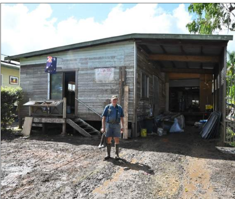
Giovanni Foltran, nel retro della casa dove ha installato il suo laboratorio di falegnameria, andato completamente distrutto. L'asta della bandiera indica il livello dell'acqua raggiunto dalle inondazioni.
