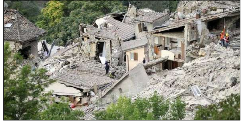
Caldarola dopo i danni subiti dal terremoto del 2016
