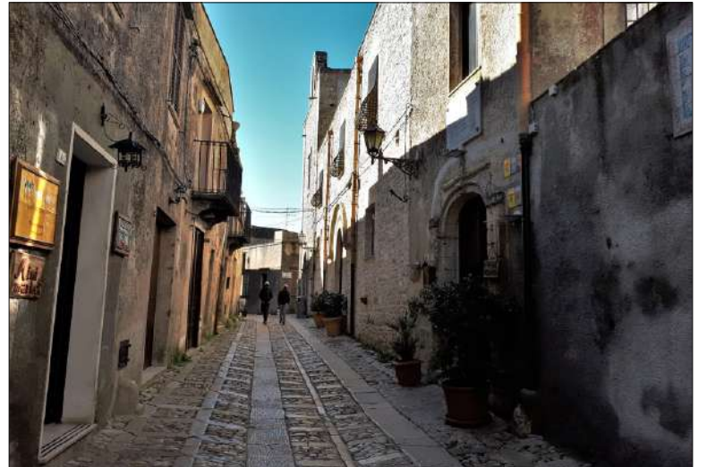
La pavimentazione delle viuzze è un misto di basolato e acciottolato
